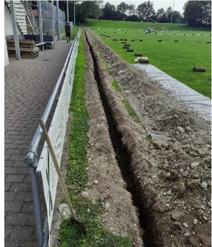
Die Bewässerungsanlage für den Hauptplatz steht vor der Fertigstellung im Frühjahr. Der 40m<sup>3</sup> Tank, der Brunnen und die Beregnungsanlage samt Rohrleitungen wurden 2024 eingebaut. Aktuell läuft die Beschaffung der Förderpumpe (27m<sup>3</sup>/h bei 7bar) und deren Steuerung.
